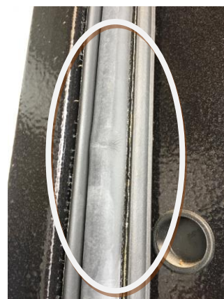
Фото 12 – торцевой монтажный зазор из монтажной пены составлял толщиной более 100 мм
