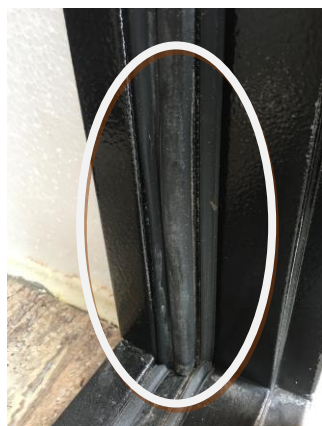
Фото 13 – эластомерные прокладки в притворах изогнутые и мятые
