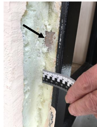
Фото 8 – при вскрытии фасадной штукатурки наблюдалась монтажная пена, наружный слой герметизации отсутствовал
