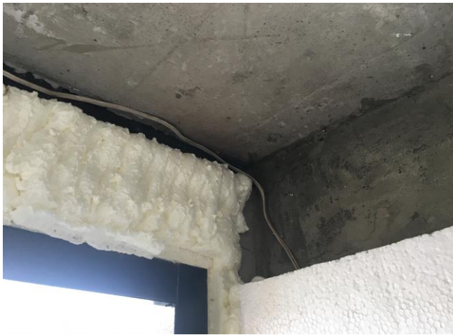
Фото 11 – при вскрытии внутренних откосов наблюдалась монтажная пена, внутренний слой пароизоляции отсутствовал
