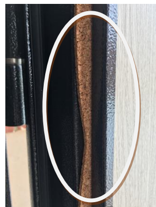
Фото 14 – эластомерные прокладки в притворах изогнутые и мятые
