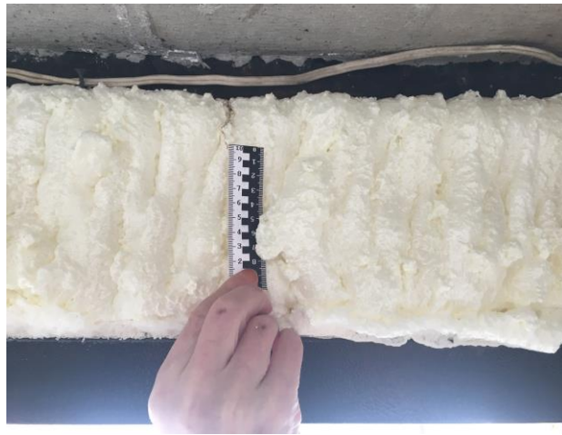
Фото 12 – торцевой монтажный зазор из монтажной пены составлял толщиной более 100 мм
